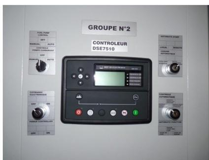
Il sistema garantisce alta affidabilità ed elevata continuità del servizio in quanto è possibile effettuare le manutenzioni alternativamente sui due gruppi senza interrompere l'erogazione di energia elettrica.
